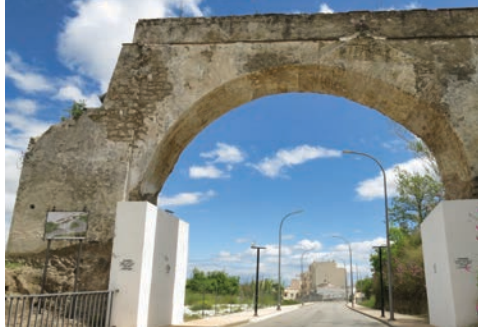
Arco de la atarjea de la primera fábrica de luz de Coín (1897), que aprovechaba el salto de agua del Molino Alto (FJVR)
